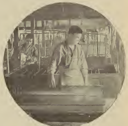
Fig. 6. - Operación de sacar la pasta de la tina para fabricar la hoja de papel
